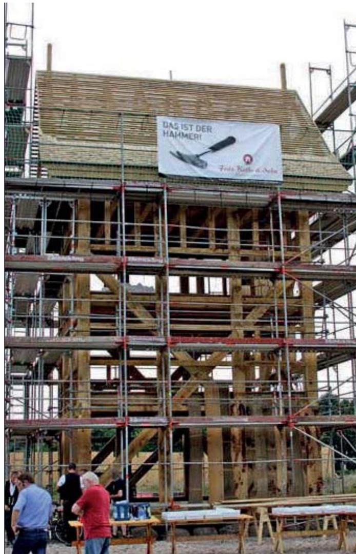
**Imposantes Bauwerk:** Der Rohbau des neuen Burgturms in Vechta. In wenigen Wochen wird das Gerüst verschwunden und die Fassadenschindeln angebracht sein.
